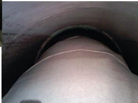
Bild 8: Zu 80% aufgeblasene Innenhülle
