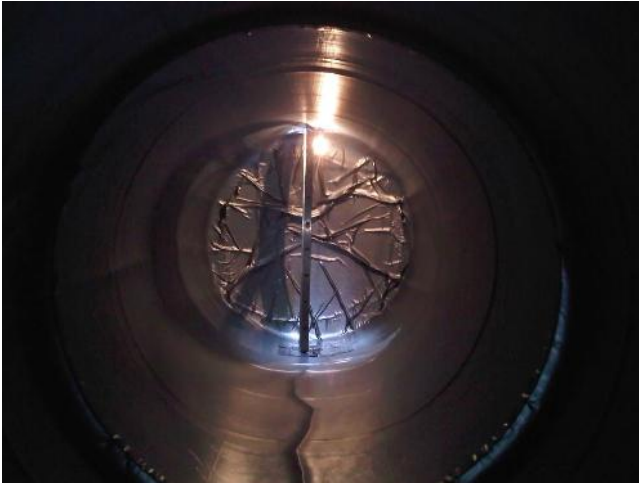
Innenhülle mit Versteifungsring
