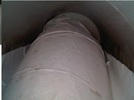
Bild 6: Zu 30% aufgeblasene Innenhülle
