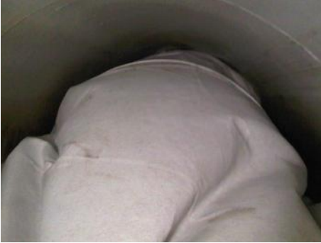
Bild 7: Zu 60% aufgeblasene Innenhülle
