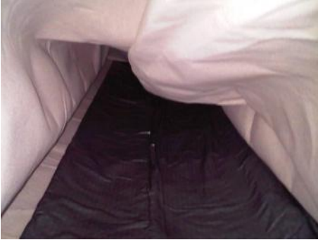
Bild 3: Im Vlies ausgerollte Innenhülle
